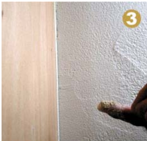
3 ふるった粉を指でクラックの中にもすり込む
