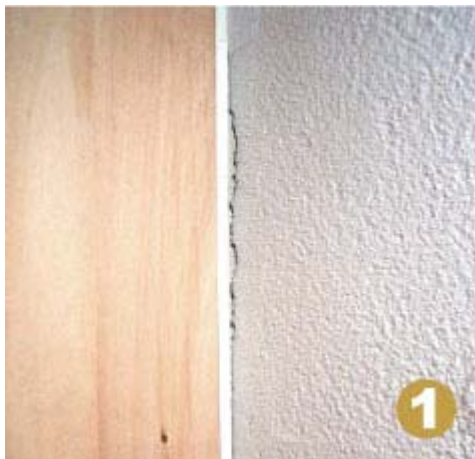
1 木部が動いてクラックが発生
